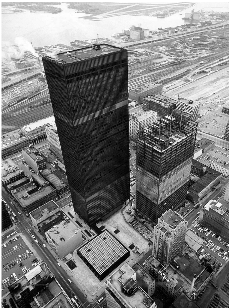
The Toronto-Dominion Centre, Toronto, Ontario – arch. L. Mies van der Rohe, J. B. Parkin and Associates oraz Bregman + Hamann widok od strony północno-zachodniej, stan z maja 1968, wszystkie trzy wieże powstały w latach 1967 – 1991 (Fot. Ron Vickers – public domain)
